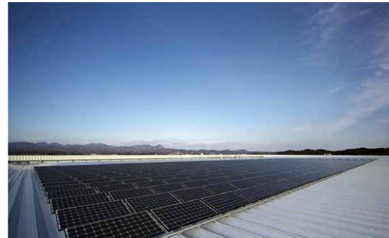
JX金属プレジジョンテクノロジー(株)掛川工場の太陽光パネル(静岡県)
